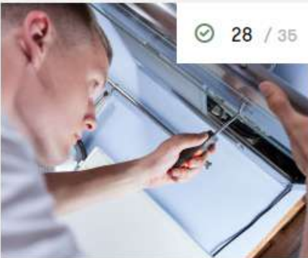
Kookplaat en afzuigkap plaatsen →
