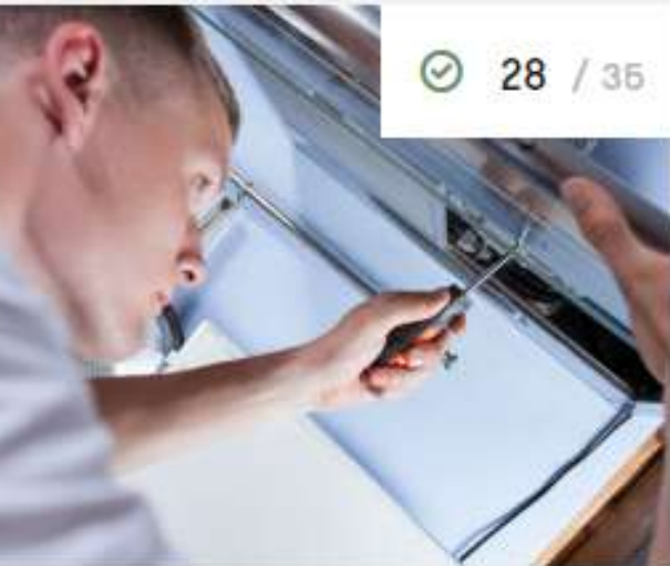
Kookplaat en afzuigkap plaatsen →
